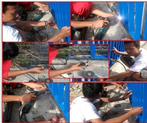
Gambar 34. Proses Pemasangan Rantai ke Pagar
