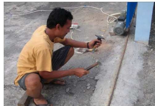
Gambar 33. Proses Pemasangan Rel Pagar
