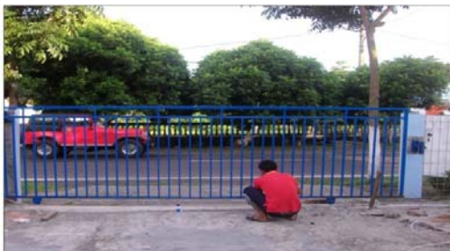
(Sumber : Perancangan alat) Gambar 30. Proses Pemasangan pagar
