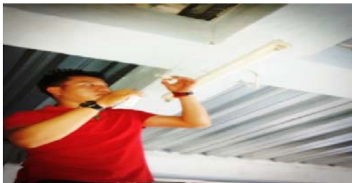
Gambar 35. Pemasangan lampu pada ruangan
