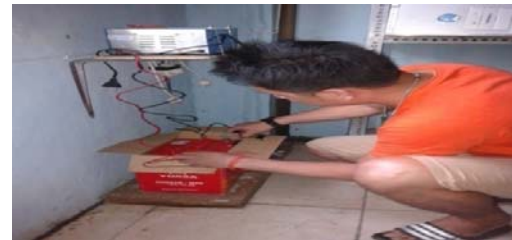
Gambar 30. Pemasangan Inverter
