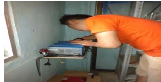
Gambar 30. Pemasangan Inverter
